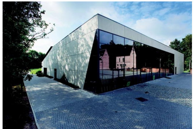
Hangar 58 Genk (Schelfhout)
